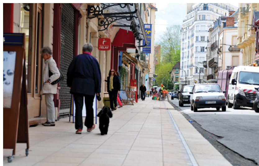
RUE FOCH, LE CHANTIER S'ACHÈVERA MI-JUILLET AVEC PLUS D'UN MOIS D'AVANCE
