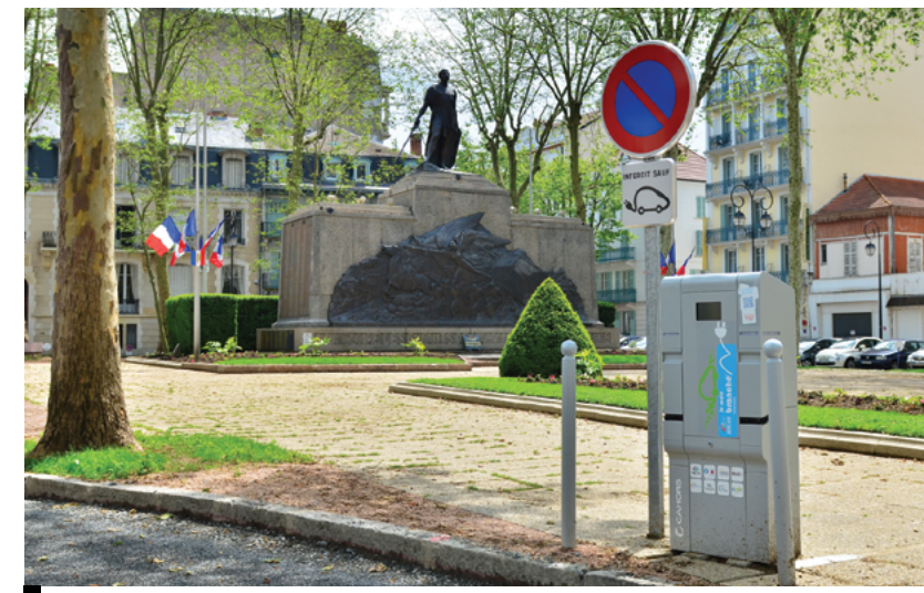
SQUARE LECLERC : RÉFECTION PARTIELLE DES ZONES DE STATIONNEMENT ET INSTALLATION D'UNE BORNE DE RECHARGE POUR LES VÉHICULES ÉLECTRIQUES
