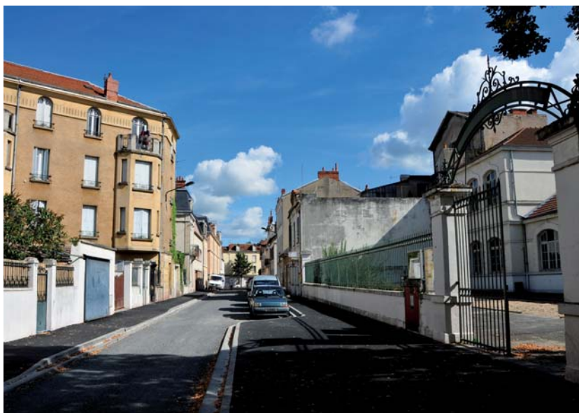
FIN DE RÉNOVATION POUR LA RUE NEUVE, QUI DESSERT L'ÉCOLE ÉLÉMENTAIRE SÉVIGNÉ-LAFAYE ET LE NOUVEAU BÂTIMENT DE LA MAISON DE RETRAITE JEANNE-COULON, RÉALISÉ PAR LA SEMIV.
